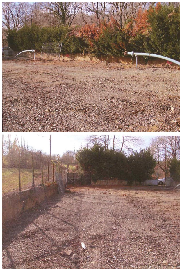
Figure 3 : Vues du site de l'ancienne station de pompage de Saint-Cricq-du-Gave après démantèlement
