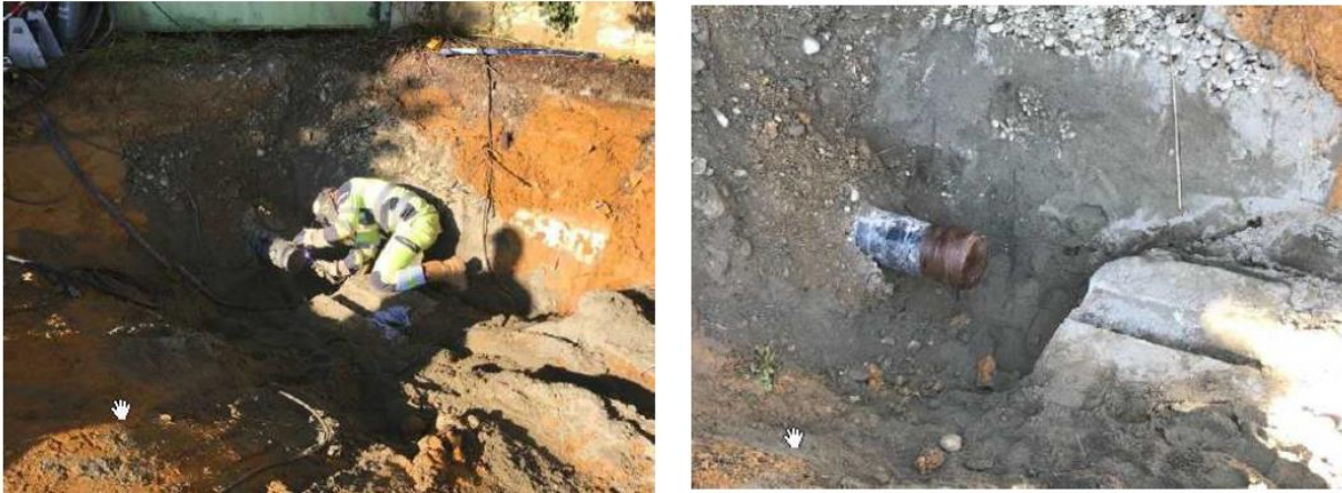
Figure 5 : Découpe et obturation des canalisations
