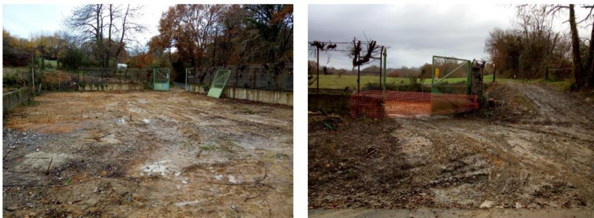
Figure 6 : Site après remblayage
